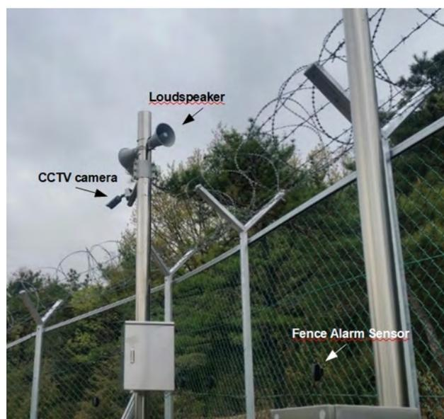
utilizza i gateway amplificati over IP del sistema **SoundLAN** di **ERMES**. Il sistema di diffusione sonora si integra con il sistema allarme perimetrale e con la televisione a circuito chiuso, consentendo al personale della sala controllo di reagire in tempo reale ai tentativi di penetrazione nell'area protetta interagendo con gli intrusi grazie alla diffusione di appropriati avvertimenti.
