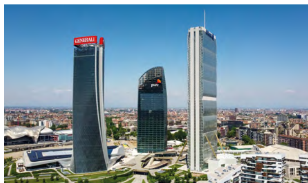
Due delle tre Torri di Citylife utilizzano PSIM di Citel + BMS
